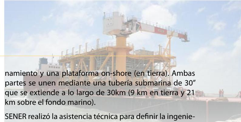
namiento y una plataforma on-shore (en tierra). Ambas partes se unen mediante una tubería submarina de 30" que se extiende a lo largo de 30km (9 km en tierra y 21 km sobre el fondo marino).
