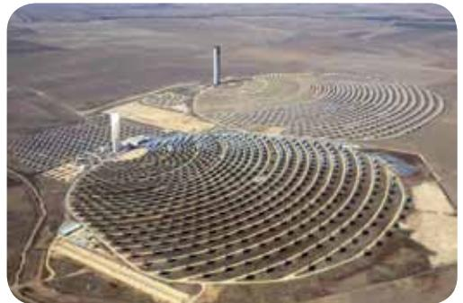
Está formada por 1255 heliostatos (conforman una superficie de 153.000 m<sup>2</sup>) y a pleno rendimiento producirá mas de 150 t. de vapor / hora a una presión de 45 bar y temperatura de 253°C. El receptor solar se aloja en el interior de una torre a
